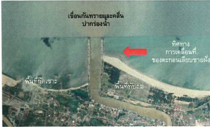
โครงสร้างเขื่อนกันทรายและคลื่น ปากร่องน้ำ สะกอม จ.สงขลา ก่อให้เกิดความเสียหายบริเวณชายหาดถัดไป
