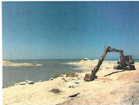
การขุดลอกร่องน้ำและถ่ายเททราย ร่องน้ำปานาเระ จ.ปัตตานี ดำเนินการโดยกรมเจ้าท่า
