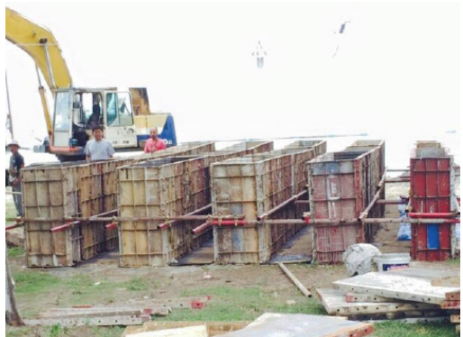
ภาพ การหล่อแท่งคอนกรีต
