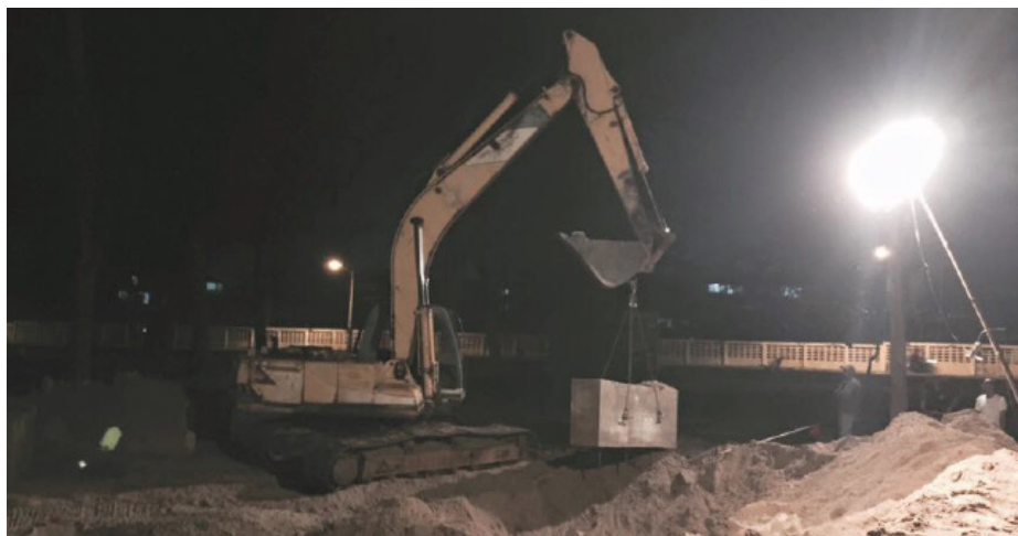
ภาพการรื้อแท่นคอนกรีตขึ้นจากทรายในคืนวันที่ ๒๕ สิงหาคม ๒๕๕๘
