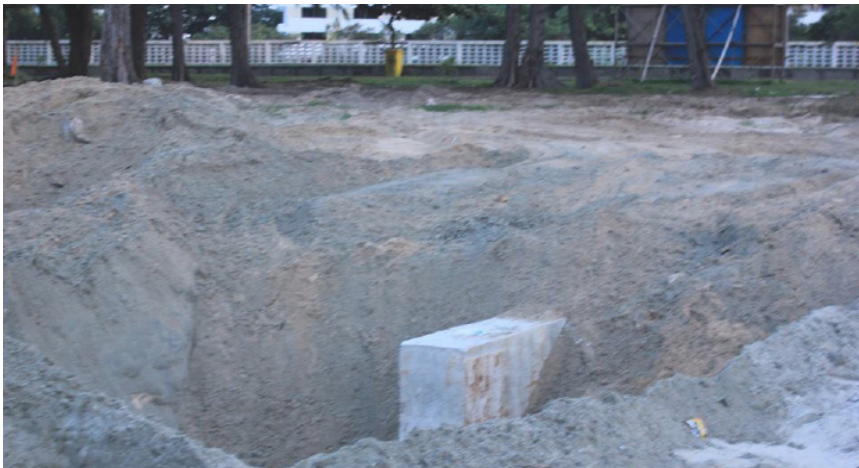
ภาพ แท่นคอนกรีตที่ถูกนำมาฝัง
