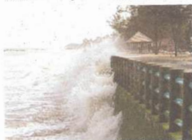
ปี 2549 เปลี่ยนเป็นกำแพงชายฝั่ง เป็นผลให้หาดทราย ถูกกัดเซาะรุนแรงขึ้นในฤดูมรสุม ชายฝั่งที่สูญเสีย หาดทรายทำให้คลื่นโถมเข้าหากำแพงโดยไม่มีหาด ทราย ช่วยดูดซับตจวมแรง
